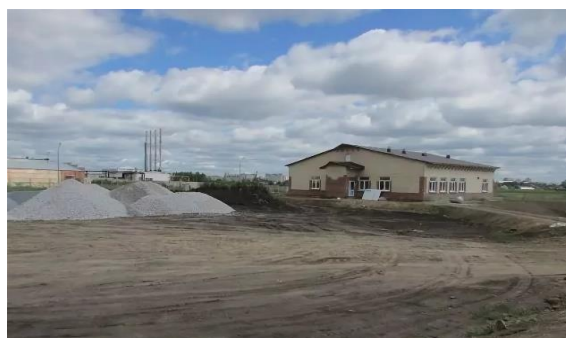
Рис. 4. Разравнивание местности под строительство [9]
